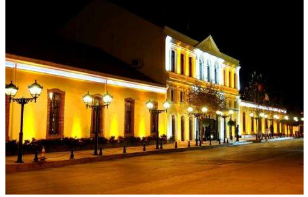
Fotoğraf 5: Montania Hotel (Gar Binası)
