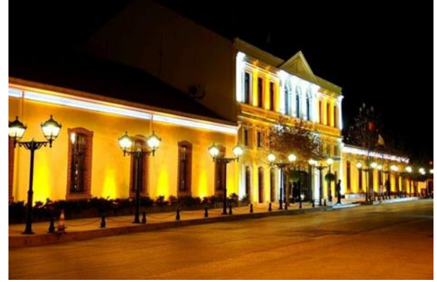
Fotoğraf 5: Montania Hotel (Gar Binası)
